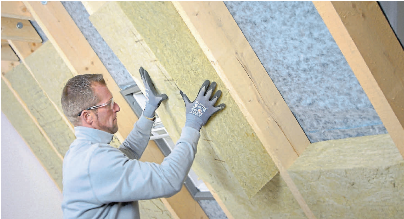
Bei Dachsanierungen ist es sinnvoll, eine Zwischen- oder Aufsparrendämmung anzubringen und über eine PV-Anlage nachzu-denken.
