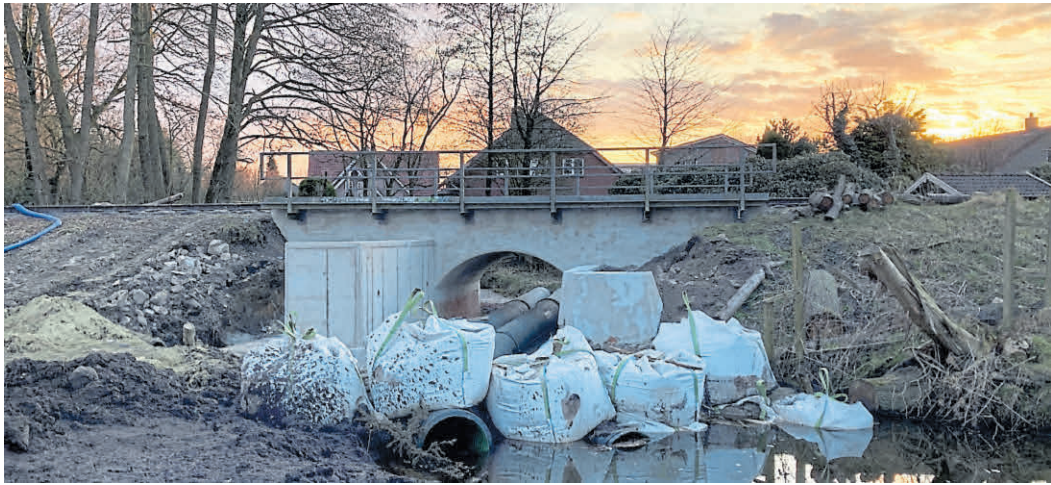
Die Soeste wurde mit Sand-Bigpacks aufgestaut und kontrolliert mittels zweier Rohre durch den Baustellenbereich geführt.
