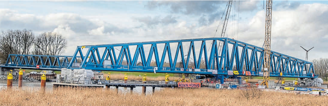
Da ruht das künftig drehbare Mittelstück der Friesenbrücke über der Ems. Derzeit wird es montiert.
