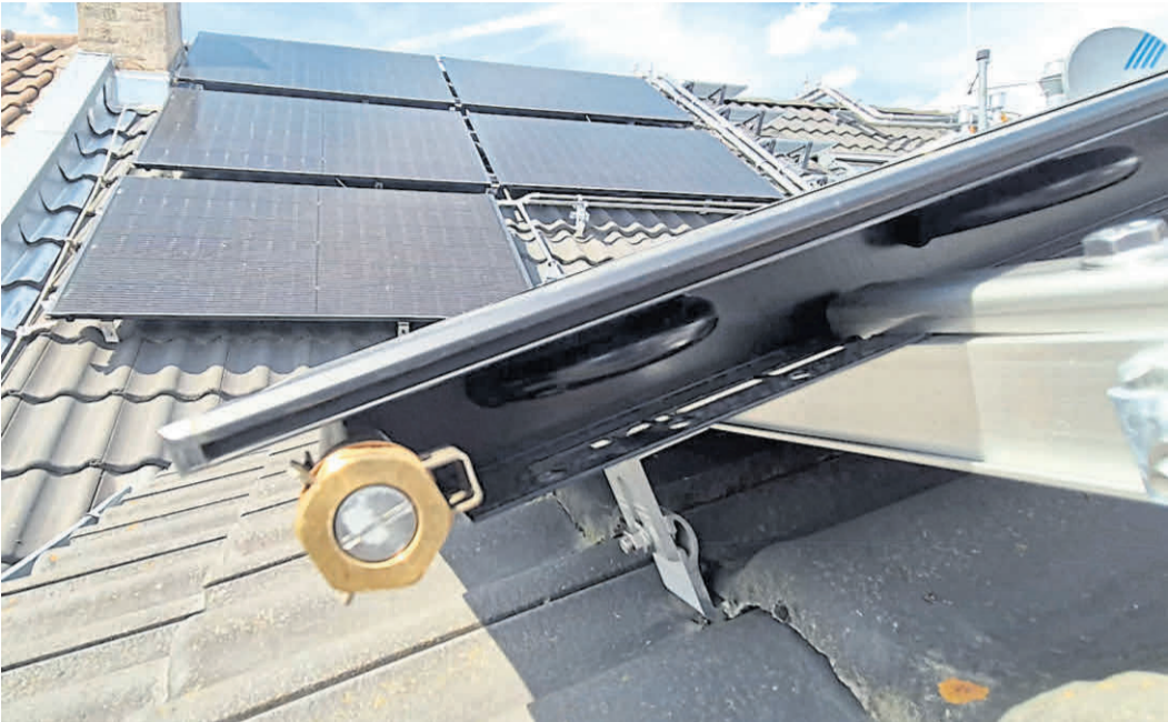
An der Oberfläche befindet sich der PV-Kollektor, der die Sonnenstrahlung aufnimmt, darunter liegt der Solarthermie-Kollektor, der Wärme bereitstellt. BILD: ERNEUERBARE.TV/DPA-TMN
