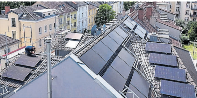
Die Hybridanlagen zur Strom- und Wärmeenergiegewinnung nutzen die Dachfläche optimal. BILD: ERNEUERBARE.TV/DPA-TMN
