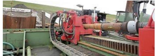
Dreht und drückt die Bohrstangen in die Erde und unter die Ems: Bohrer am Deich nahe Petkum. BILD: TORSTEN VON REEKEN
