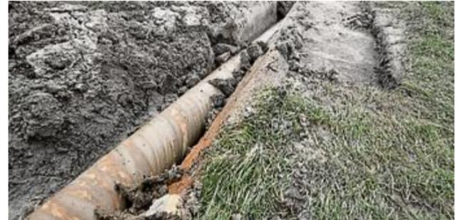
28 Meter unter dem Deich, 21 Meter unter der Ems-Sole: das Bohrgestänge. BILD: TORSTEN VON REEKEN
