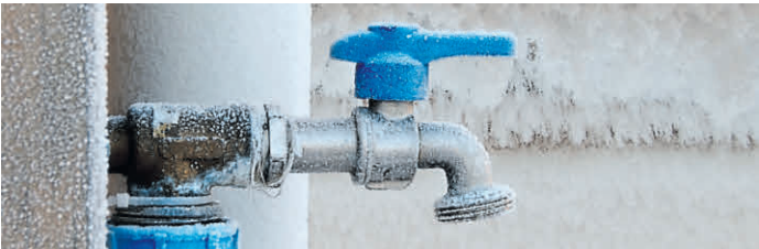
Wasserleitungen müssen im Winter unbedingt geleert werden, um Frostschäden und Probleme mit der Versicherung zu vermeiden
