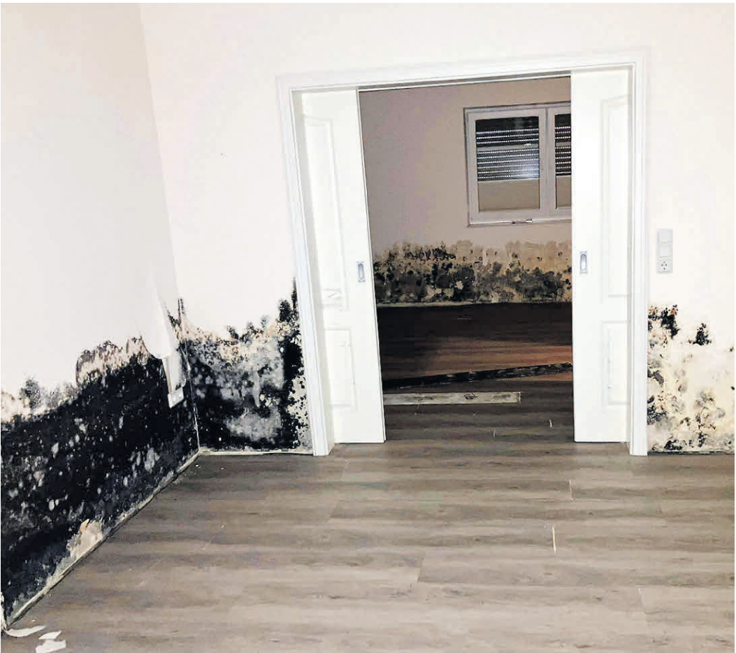
Schimmel, soweit das Auge reicht: Der Boden im Neubau quillt auf. Und die Türen sind allesamt verzogen.
