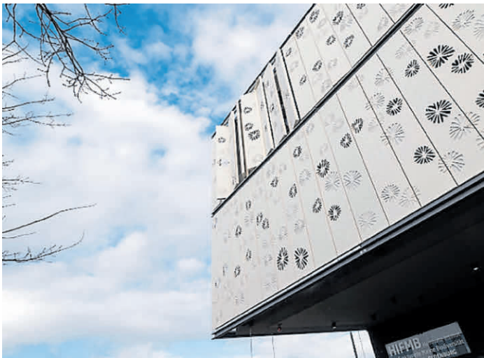
Am Neubau sind 569 weiße Fassadenelemente verankert, deren besondere Fräsung von Korallen inspiriert ist.
