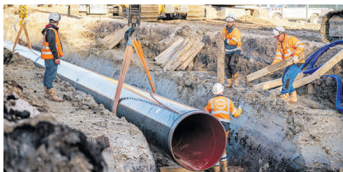
Die ersten Rohre für die neue Gasleitung Etzel-Wardenburg wurden bereits verlegt.
