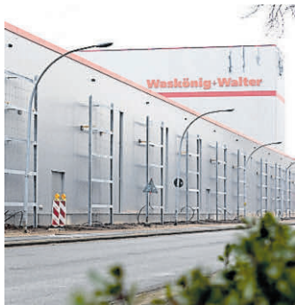
Außenansicht der Hallenerweiterung „Nordwest“ an der Friedhofstraße in Ramsloh: Die Rankgitter für die Begrünung sind bereits montiert.
