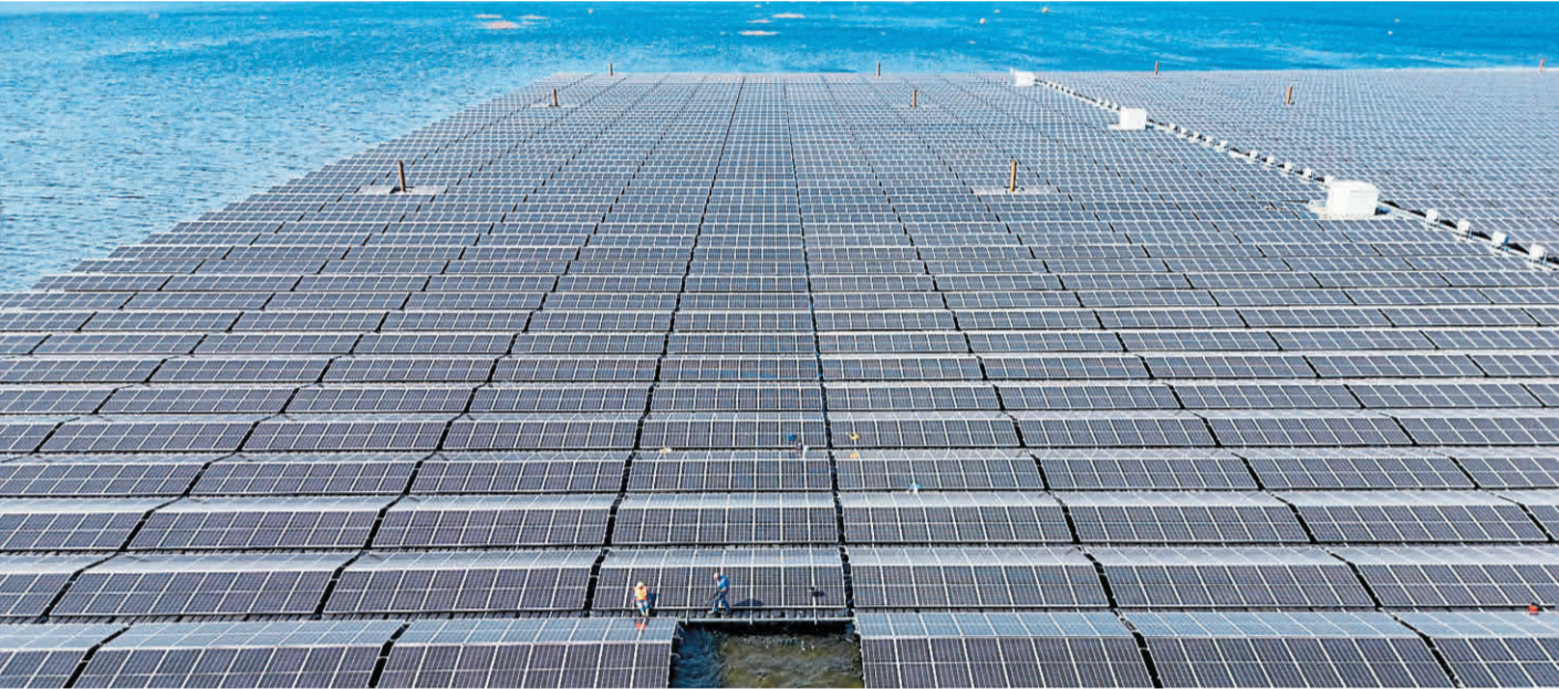
Eine schwimmende PV-Anlage auf dem Cottbuser Ostsee, einem gefluteten ehemaligen Braunkohletagebau
