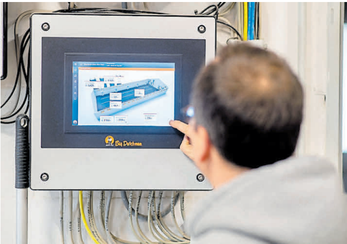
Auf einem Display werden die Temperatur und der Lüftungsbedarf eines Stalls angezeigt.
