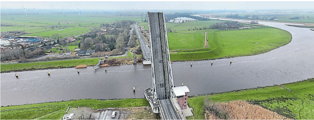
Die Klappbrücke ist nach dem Hebevorgang stecken geblieben.
