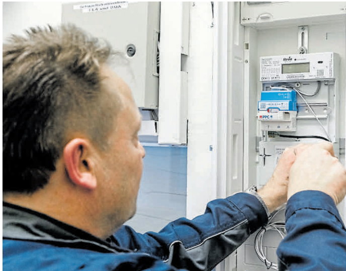
Ein Elektriker montiert einen digitalen Stromzähler mit einem Smart-Meter-Gateway. DPA-ARCHIVBILD: SCHOLZ
