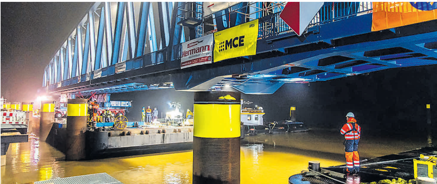
Riesig überragt das Mittelstück der neuen Friesenbrücke die Pontons. Es soll nach einer Drehung der Pontons nach links bewegt werden.
