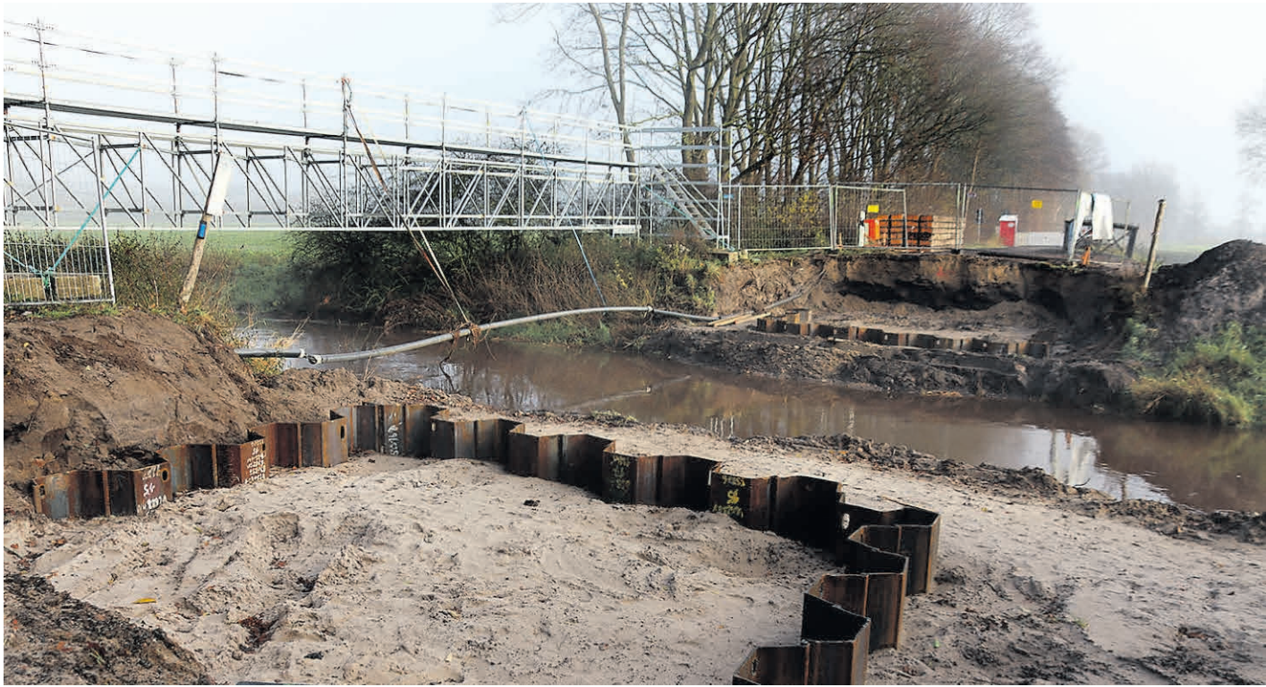
Die Spundwände für die neue Brücke am Oldenburger Weg sind inzwischen gesetzt. Ein Statiker-Streit hat den Neubau deutlich verzögert.
