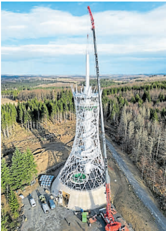
Mit einem Kran werden die Einzelteile des Besenstiels auf dem Aussichtsturm aufgesetzt.
