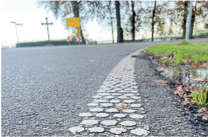
Am Abzweig nach Falkenberg sind die Fahrbahn-Markierungen installiert worden, die beim Überfahren Geräusche von sich geben.
