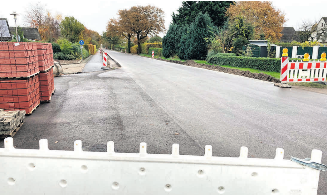
Die Sanierung der Beverbrucher Straße läuft auf Hochtouren. Teilweise ist schon eine neue Deckschicht aufgebracht worden.
