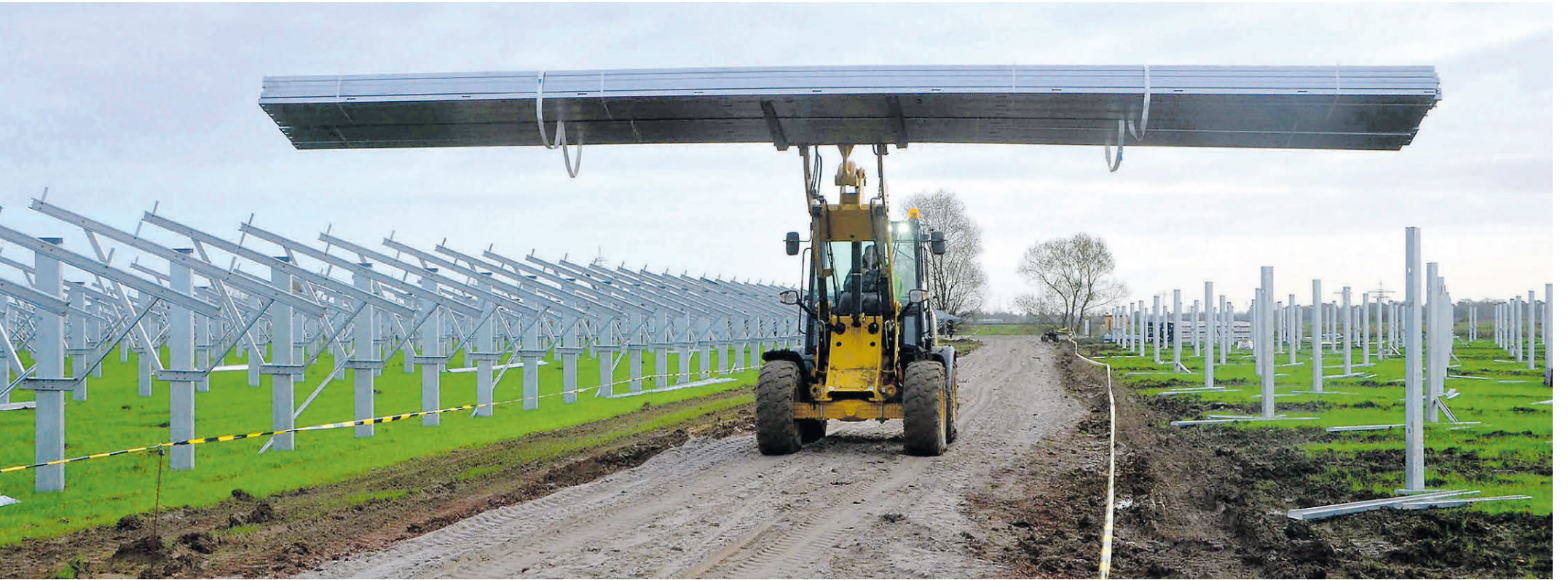
Platz für 26.000 Solarmodule: 10.000 Pfeiler tragen die Photovoltaikanlage. Darunter kann künftig GPS-gesteuert weiter gemäht werden.
