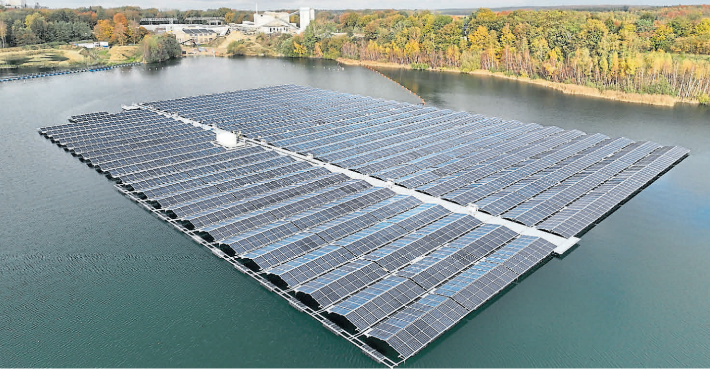
Die schwimmende Photovoltaikanlage auf dem Baggersee des Kalksandsteinwerks in Höltinghausen ist mit 85 mal 132 Meter etwas größer als ein Fußballfeld. Die PV-Anlage hat eine Systemleistung von 2,2 Megawatt Peak (MWp). BILD: 1PUNKT5 GMBH
