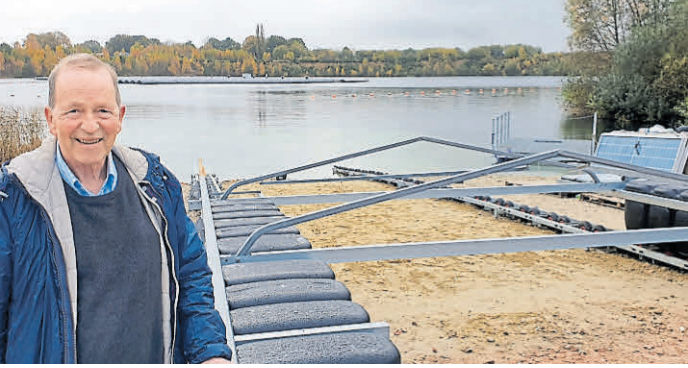
Die schwimmende Photovoltaikanlage auf dem Baggersee des Kalksandsteinwerks in Höltinghausen ist mit 85 mal 132 Meter etwas größer als ein Fußballfeld. Die PV-Anlage hat eine Systemleistung von 2,2 Megawatt Peak (MWp). BILD: 1PUNKT5 GMBH
