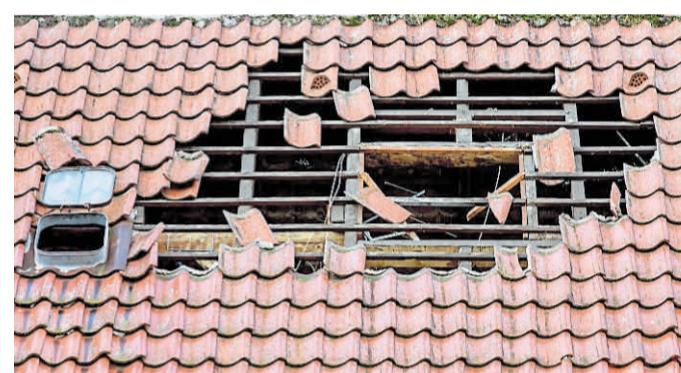
Ein Sturm kann schon mal das Dach abdecken. Spezielle Sogklammern sollen das verhindern.
