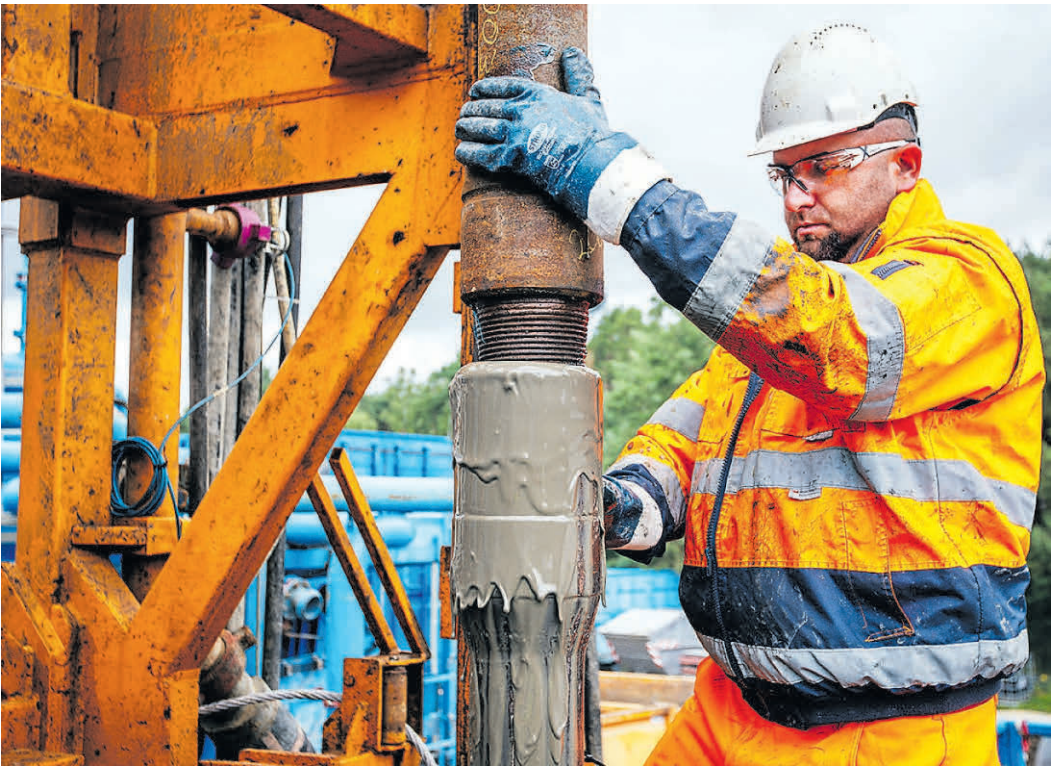
Ein Bohrgestänge wird auf einer Baustelle für die Erweiterung der Geothermie-Anlage auf dem Bohrturm montiert. Hier gebe es großes Potenzial, sagt der BVEG. DPA-BILD: BÜTTNER
