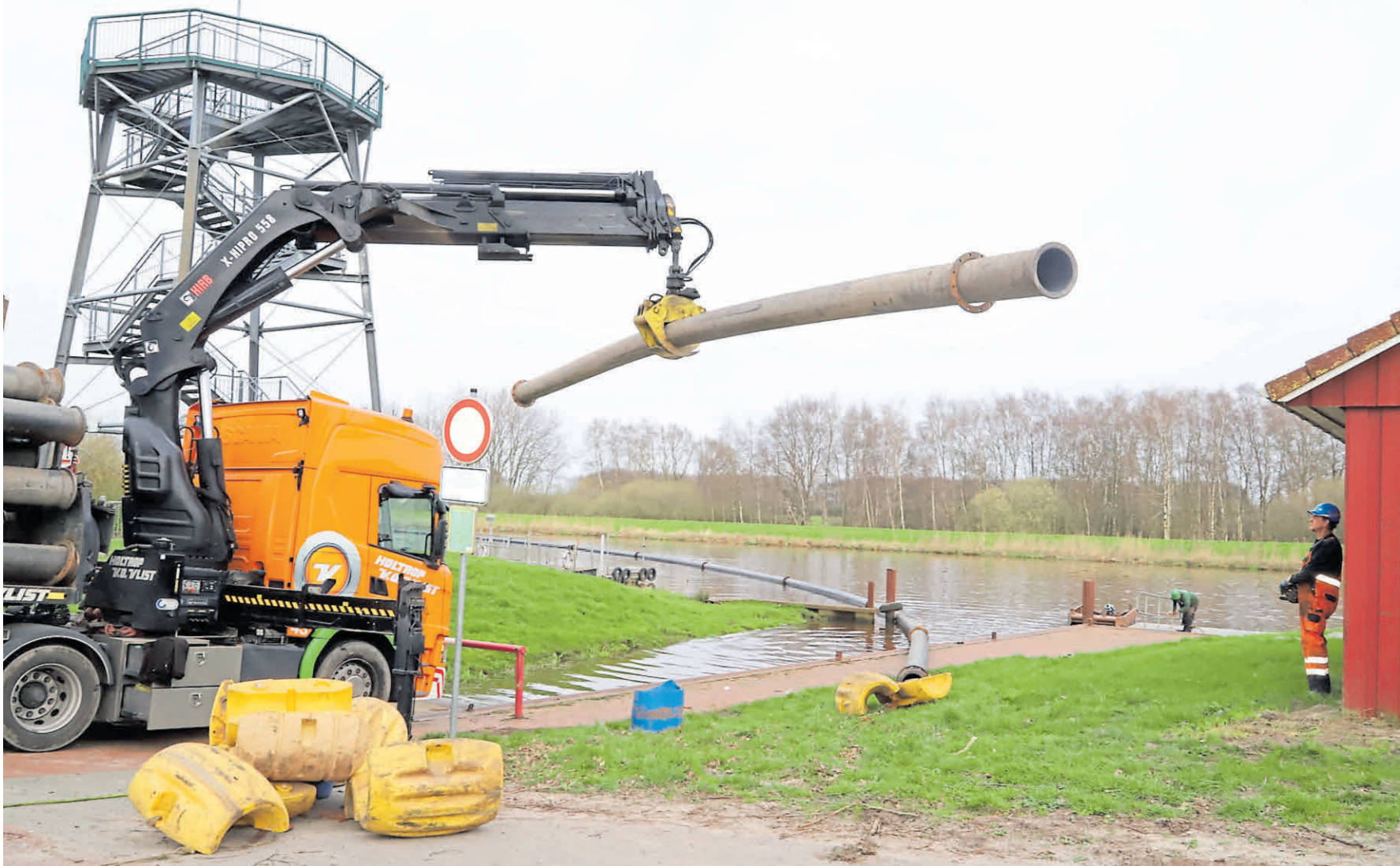
Die Rohrsysteme auf Soeste und Barßeler Tief sind verlegt worden. Die Entsandungsmaßnahmen können in Kürze beginnen.
