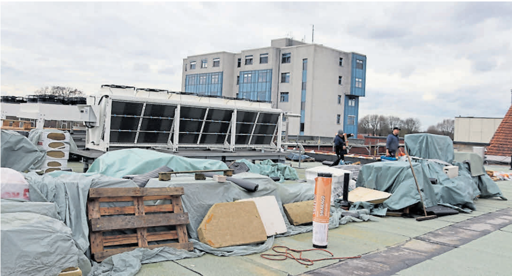
Große Rückkühler stehen auf dem Neubau-Dach am St.-Marien-Hospital Friesoythe. Sie sind Teil der Heizungs- und Lüftungsanlage, die nicht nur Patientenzimmer, sondern besonders auch den neuen OP-Trakt versorgen muss.
