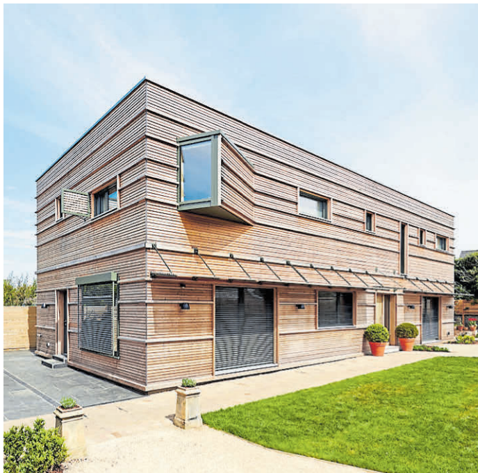
C2C-Konzept einer ungewöhnliche Fertighausfassade mit nachhaltigen Baustoffen.
