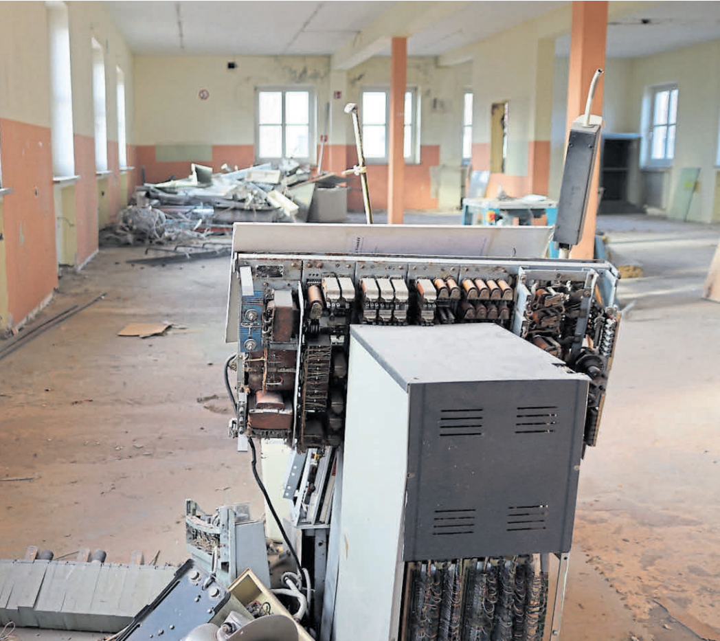
Im Obergeschoss wurden früher die Briefe sortiert. Hier werden gerade die alte Technik und die Einbauten entfernt.
