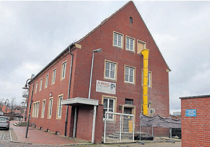
Die Alte Post ist von der Stadt Friesoythe als „ortsbildprägend“ eingestuft worden. Die Fassade bleibt bei der Sanierung erhalten, gedämmt wird von innen.
