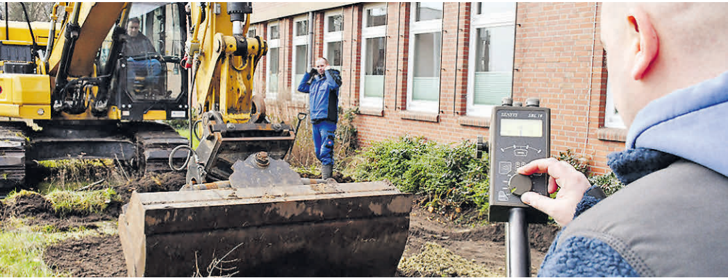
Das Messgerät sendet ferromagnetische Strahlen in den Boden und misst die Reflektionen durch eisenhaltige Gegenstände in bis zu fünf Metern Tiefe.
