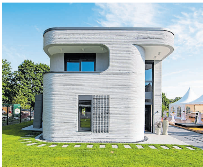
An der Außenfassade des ersten 3D Druckhauses sieht man die mittels eines 3D-Betondruckers aufgetragenen Betonschichten.
