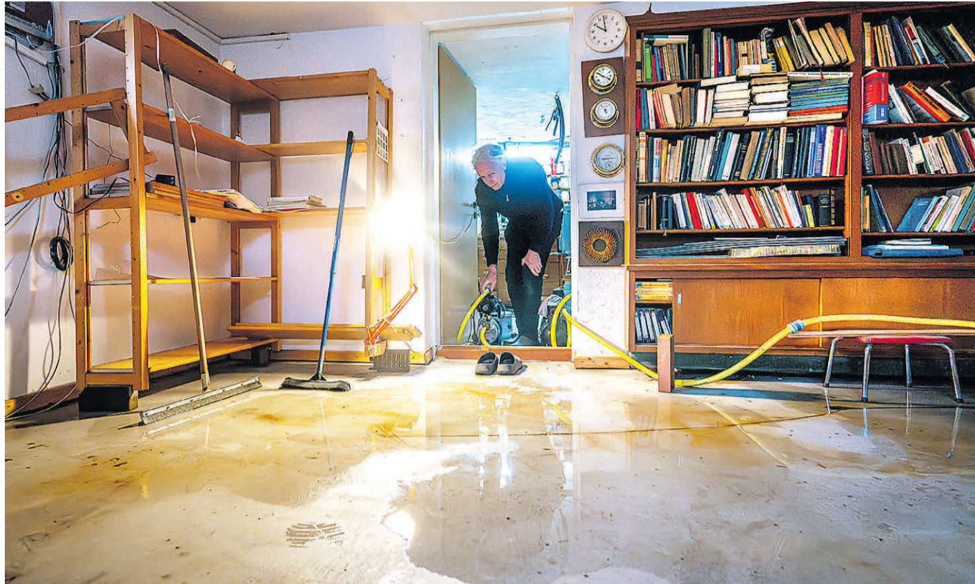
Ein Wohnhaus in Bremen, das beim Hochwasser im Januar beschädigt wurde: Für immer mehr Hausbesitzer werden Starkregen und Jahrhundertsommer eine Gefahr fürs Eigenheim.
